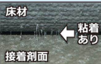
ビニル系床材への張替えのためタイルカーペットを剥離
