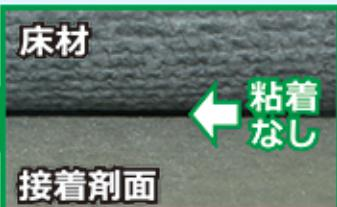
ビニル系床材への張替えのためタイルカーペットを剥離
